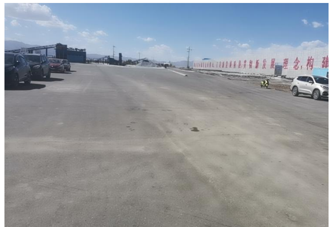
厂区道路硬化
