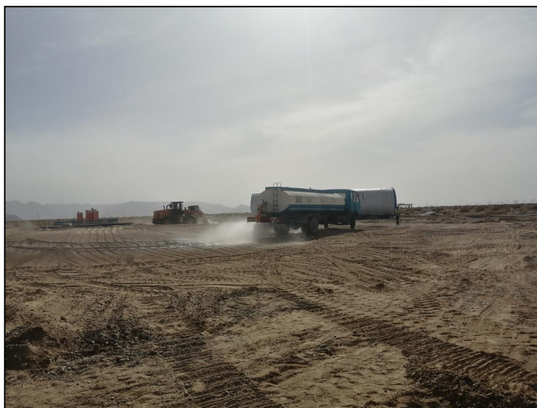
施工期洒水降尘
