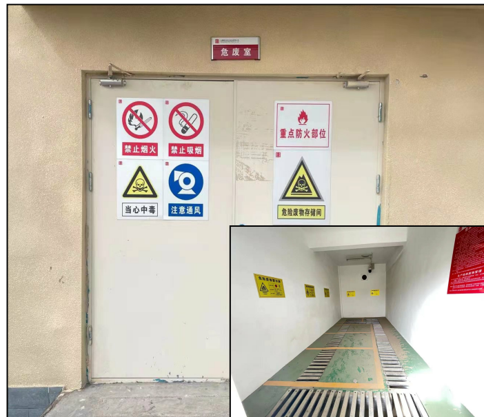
危废间及内部（和六标段共用）
